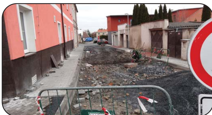
Práce v ulici Kymrova
