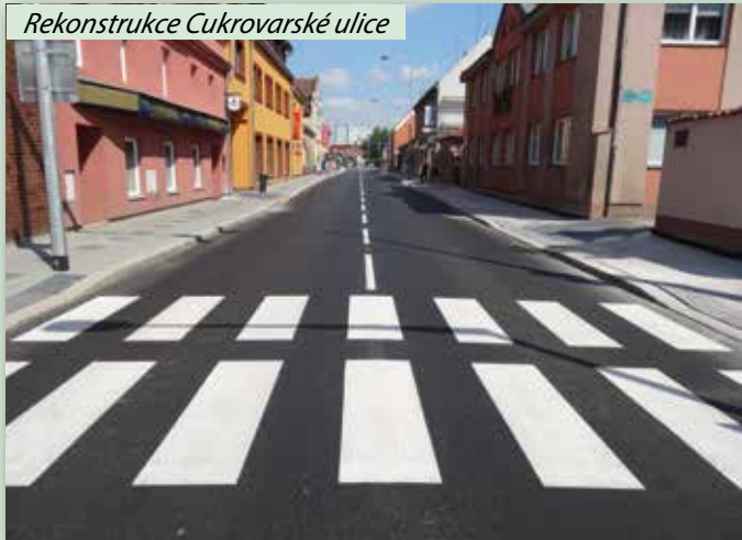
Rekonstrukce Cukrovarské ulice
