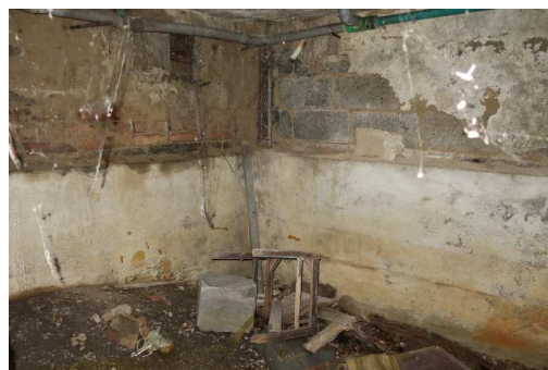
Sklep dvojdomu č.p. 140 a 141
