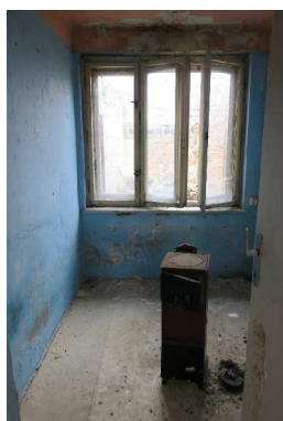
Kuchyně domu č.p. 140
