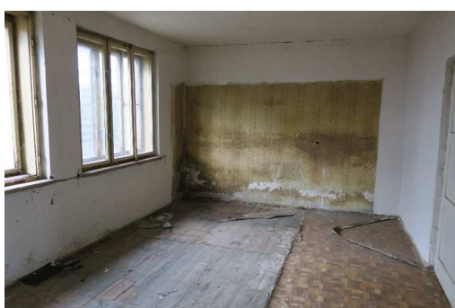
Obývací pokoj domu č.p. 141
