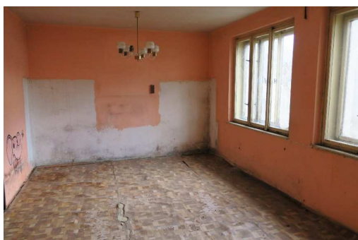
Obývací pokoj domu č.p. 140
