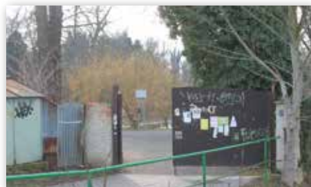
Vchod do zámeckého parku projde rekonstrukcí
