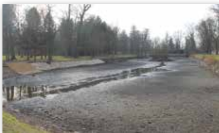
Bylo požádáno o dotaci na opravu břehů rybníka v zámeckém parku
