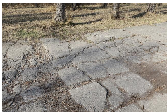
Betonové panely na pozemku
