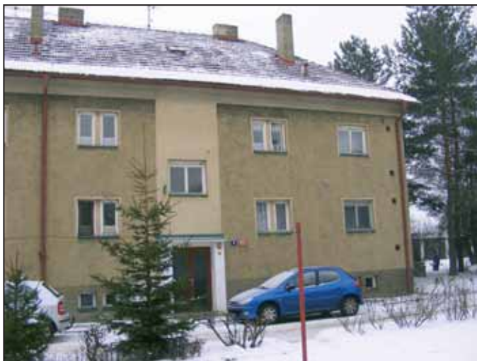
V příštím roce bude už tento pohled na domy v ulici U Párnků minulostí. Nástavby navíc tyto nemovitosti zhodnotí.
