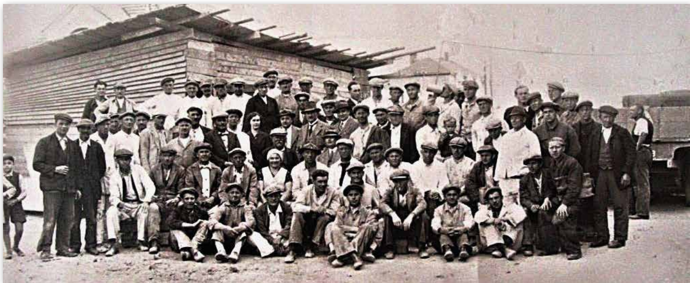
Dělníci na stavbě školy
