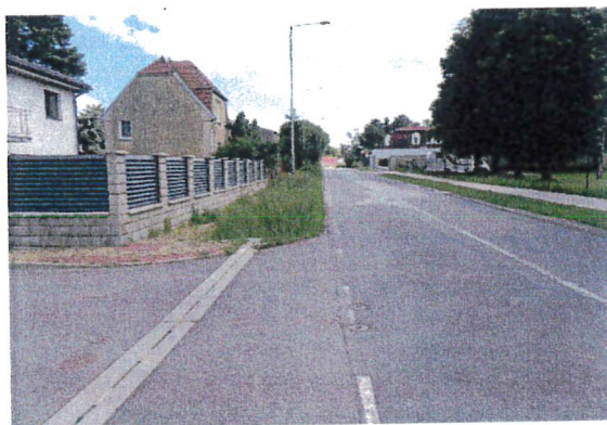
Komunikace vedoucí podél pozemku p.č. 479/4
