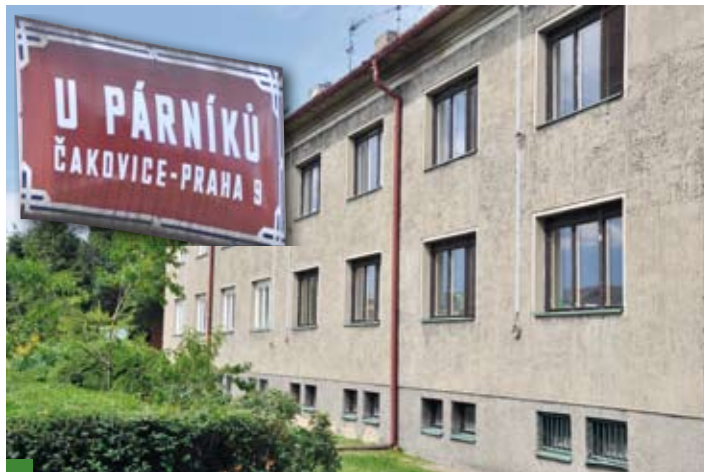
Na sídlišti „U Párníků“ zbývá ještě jeden bytový dům k rekonstrukci
