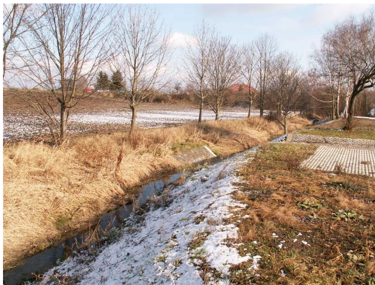
obr. 26 – úsek 11, pohled po proudu
