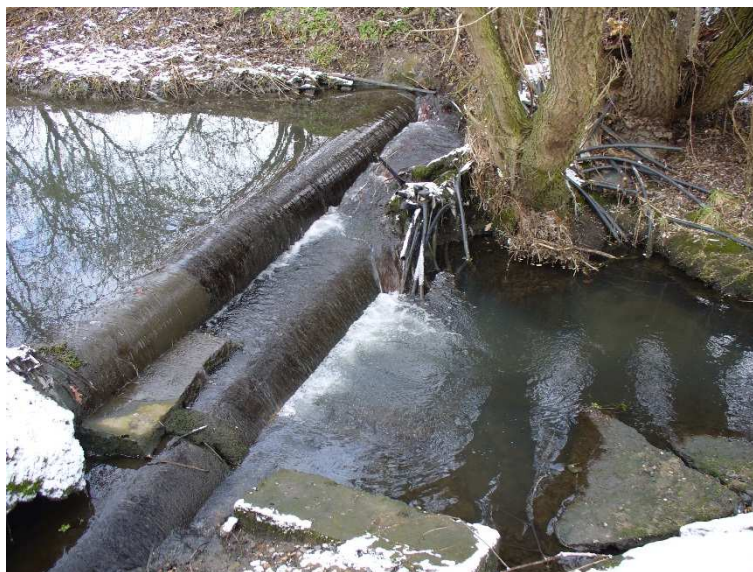
obr. 19 – úsek 08, pohled z pravého břehu na stupeň navržený k odstranění
