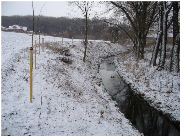
obr. 5 – úsek 02, pohled po proudu od cestního mostu (objekt č. 2)
